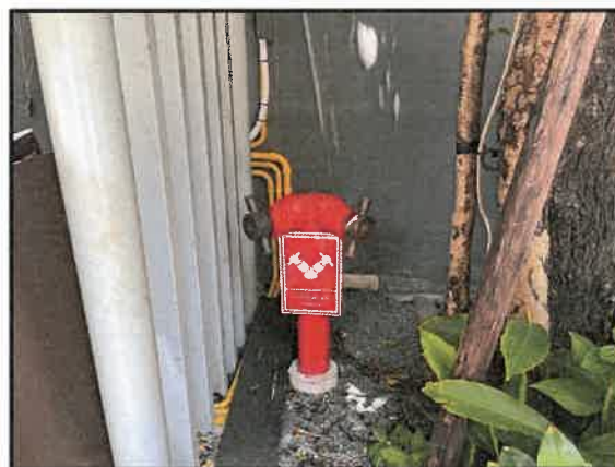
รูปที่ 3-18 ทิวรับน้ำดับเพลิงนอกอาคาร
