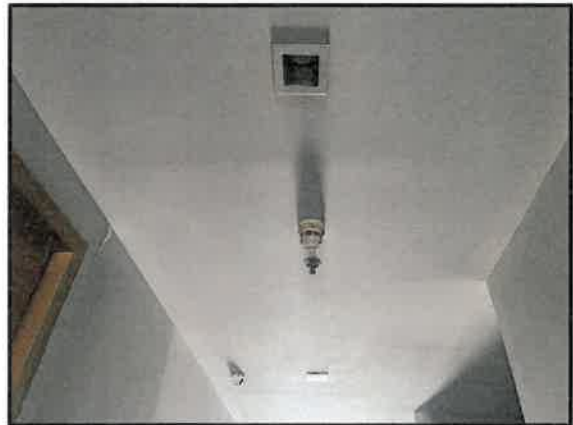
รูปที่ 3-23 เครื่องตรวจจับควันและเครื่องตรวจจับความร้อน
