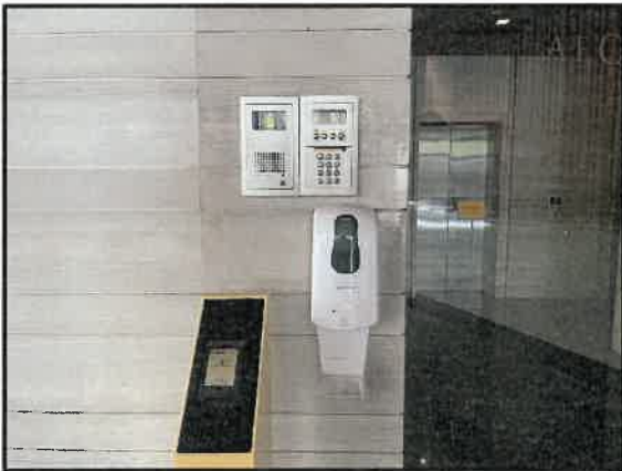
รูปที่ 3-41 คีย์การ์ดควบคุมการเข้า-ออกอาคาร
