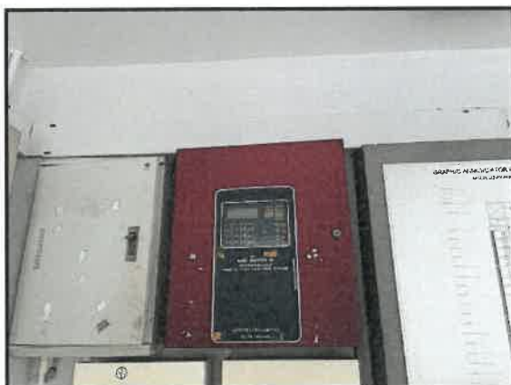
รูปที่ 3-21 ระบบหัวจ่ายน้ำดับเพลิงอัตโนมัติและแผงควบคุม Fire Alarm Control
