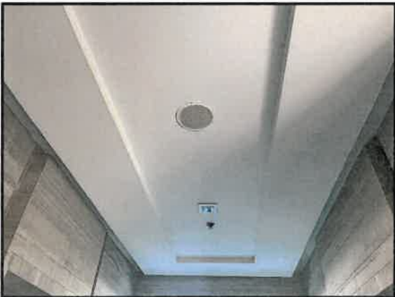
รูปที่ 3-23 เครื่องตรวจจับควันและเครื่องตรวจจับความร้อน
