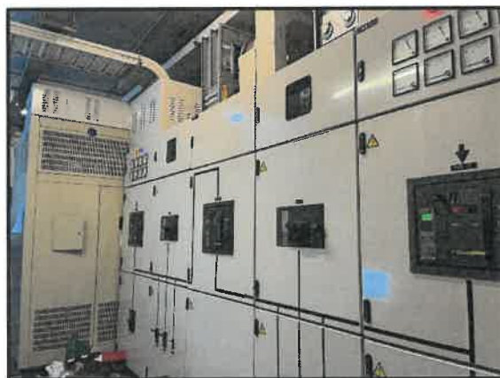
รูปที่ 3-15 ติดตั้ง Transformer ชนิด Dry-Type
